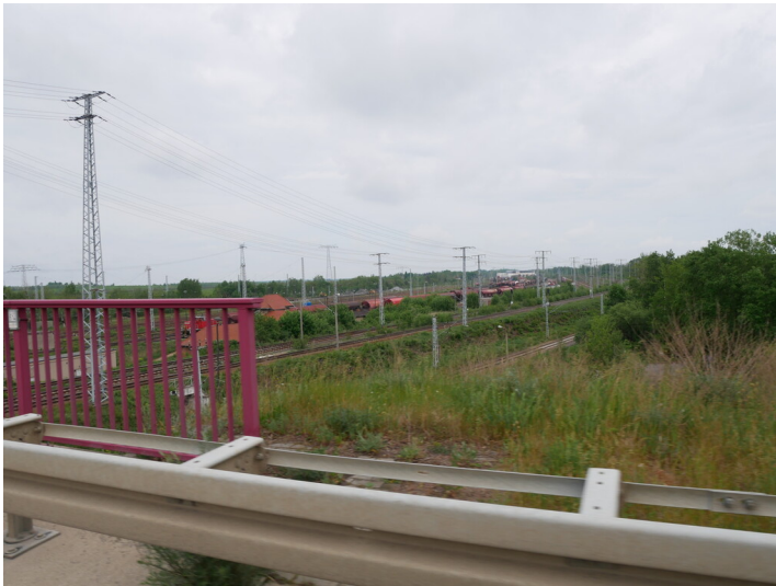
Güterbahnhof Senftenberg Fotograf/Urheber: Kirsten Krepelin
