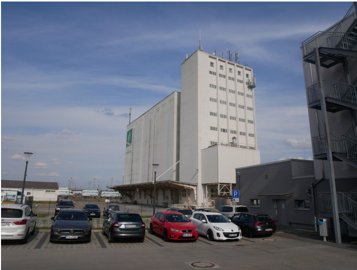
Getreidesilo Fotograf/Urheber: Franz Dietzmann
