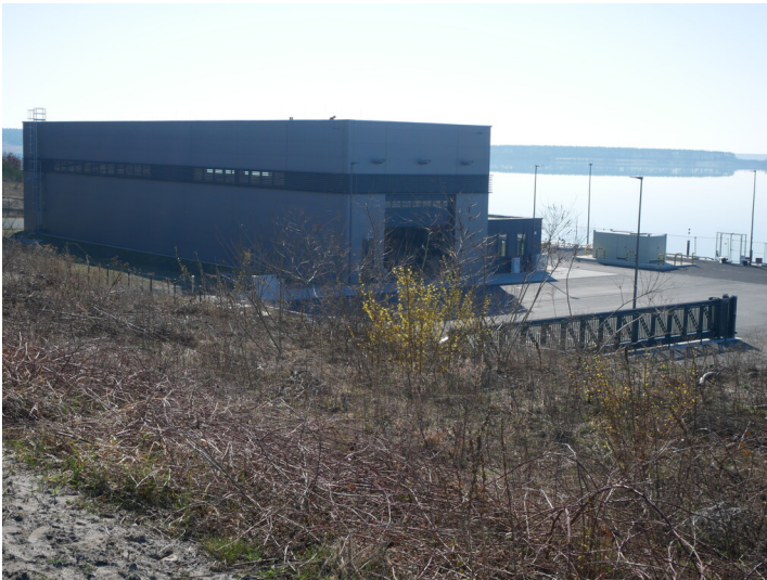
Sanierungsstützpunkt Sedlitz Fotograf/Urheber: Franz Dietzmann
