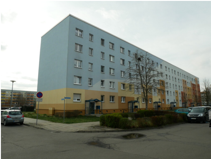
Wohnkomplex Fotograf/Urheber: Dr. Barbara Kündiger
