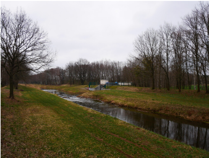
Deichsiel Biehlen Fotograf/Urheber: Kirsten Krepelin
