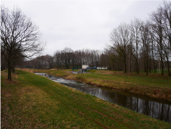
Deichsiel Biehlen Fotograf/Urheber: Kirsten Krepelin
