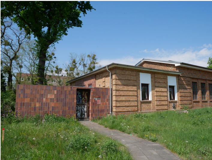
Tagesanlagen Ackerstraße Fotograf/Urheber: Tanja Trittel
