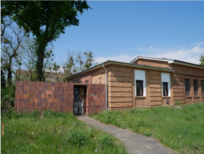
Tagesanlagen Ackerstraße Fotograf/Urheber: Tanja Trittel
