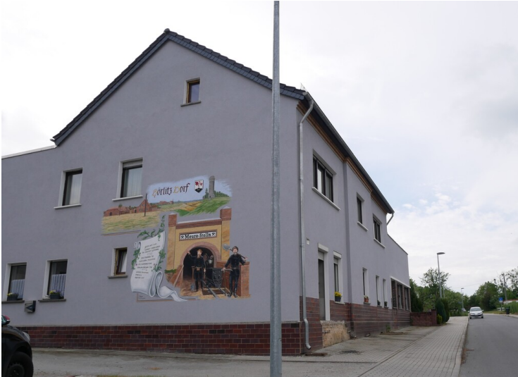
Fassadenmalerei Fotograf/Urheber: Kirsten Krepelin
