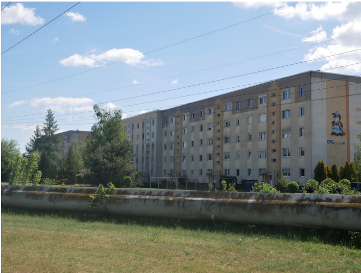
Nördliche Stadterweiterung Großräschen Fotograf/Urheber: Franz Dietzmann
