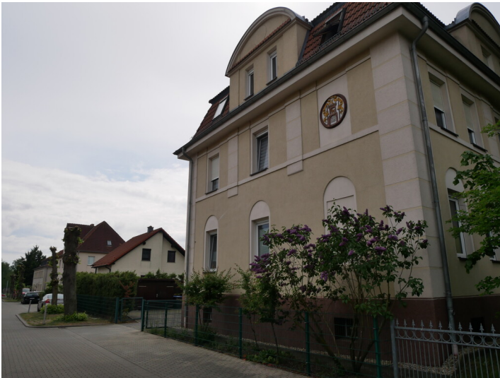
Beamensiedlung Brikettfabrik Meurostolln Fotograf/Urheber: Tanja Trittel
