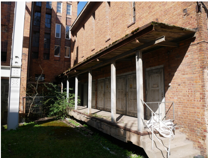
Schaltwarte und Bürogebäude des Kraftwerks der Brikettfabriken Renate und Eva Fotograf/Urheber: Franz Dietzmann
