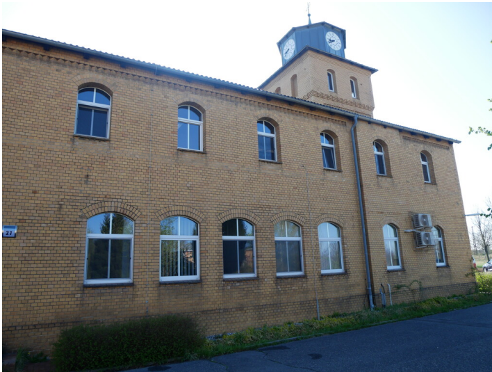
Verwaltungsgebäude der Brikettfabriken Renate und Eva Fotograf/Urheber: Franz Dietzmann
