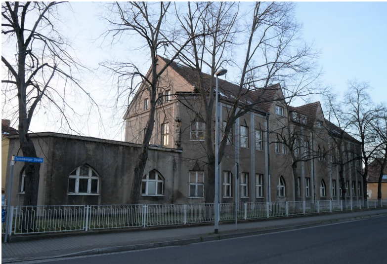
Verwaltungsgebäude der Halleschen Pfännerschaft AG Fotograf/Urheber: Tanja Trittel
