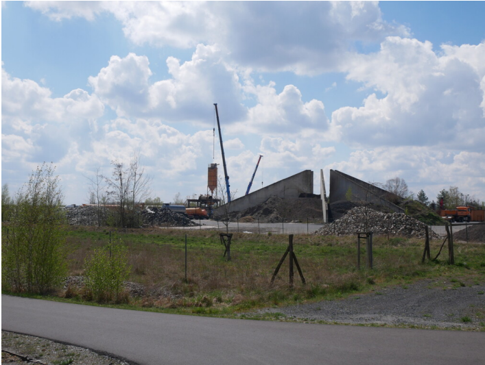
Asphaltmischwerk Freienhufen Fotograf/Urheber: Franz Dietzmann
