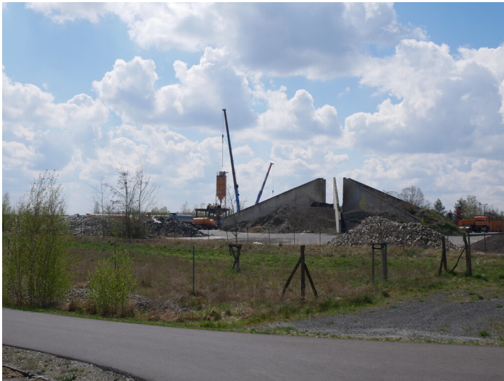
Asphaltmischwerk Freienhufen Fotograf/Urheber: Franz Dietzmann
