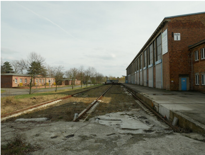
Produktionshallen der WISAG im Industriepark Marga Fotograf/Urheber: Kaja Boelcke
