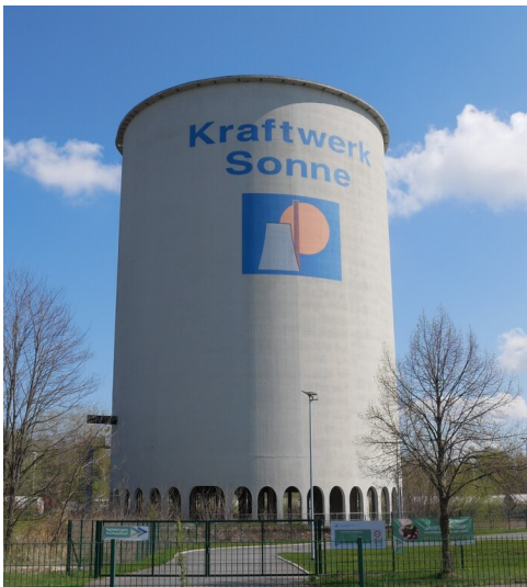
Kühlturm des Kraftwerks Sonne Fotograf/Urheber: Franz Dietzmann
