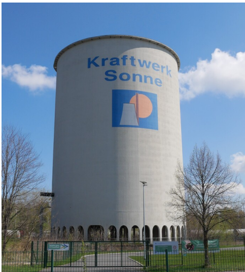
Kühlturm des Kraftwerks Sonne Fotograf/Urheber: Franz Dietzmann
