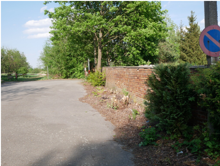
Brikettfabrik Meurostolln Fotograf/Urheber: Tanja Trittel
