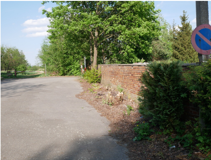
Brikettfabrik Meurostolln Fotograf/Urheber: Tanja Trittel
