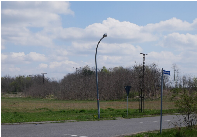
Freileitung Tagebau Meuro Fotograf/Urheber: Franz Dietzmann
