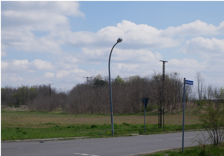
Freileitung Tagebau Meuro Fotograf/Urheber: Franz Dietzmann
