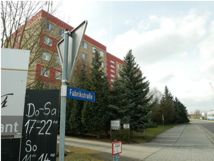
ehem. Werkverwaltung Fotograf/Urheber: Kaja Boelcke
