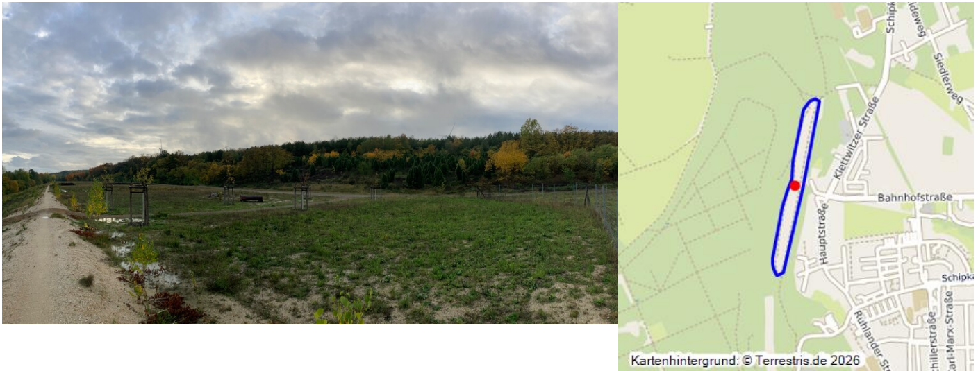
Böschungssystem der Hochkippe Schipkau Fotograf/Urheber: Tanja Trittel
