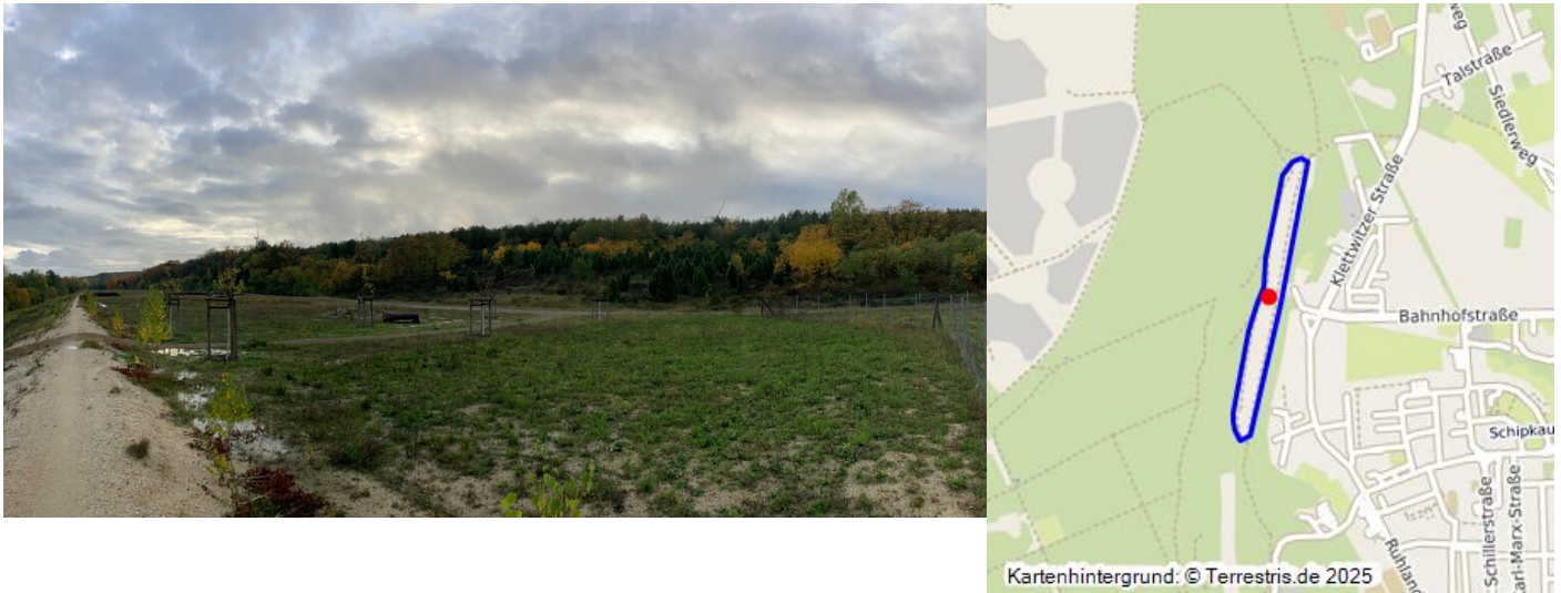
Böschungssystem der Hochkippe Schipkau Fotograf/Urheber: Tanja Trittel
