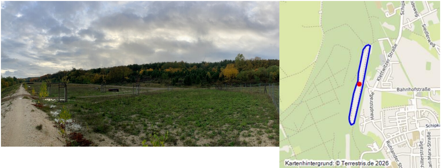
Böschungssystem der Hochkippe Schipkau Fotograf/Urheber: Tanja Trittel
