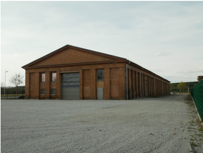
Werkstattengebäude am westlichen Rand des Industrieparks Marga Fotograf/Urheber: Kaja Boelcke
