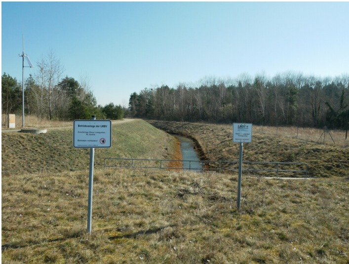
Oberer Landgraben Fotograf/Urheber: Kirsten Krepelin
