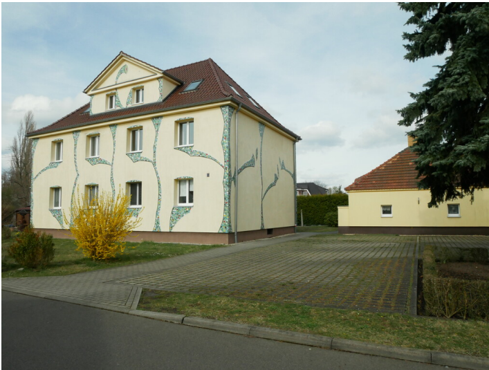
Siedlung Elster für Arbeiter der Grube Marga Fotograf/Urheber: Kaja Boelcke
