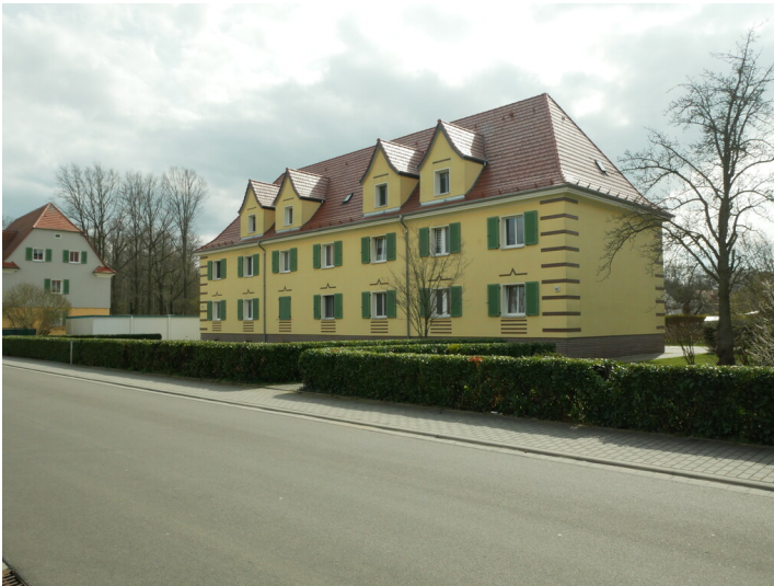
Siedlung für Arbeiter der Grube Marga, Straße der Jugend Fotograf/Urheber: Dr. Barbara Kündiger
