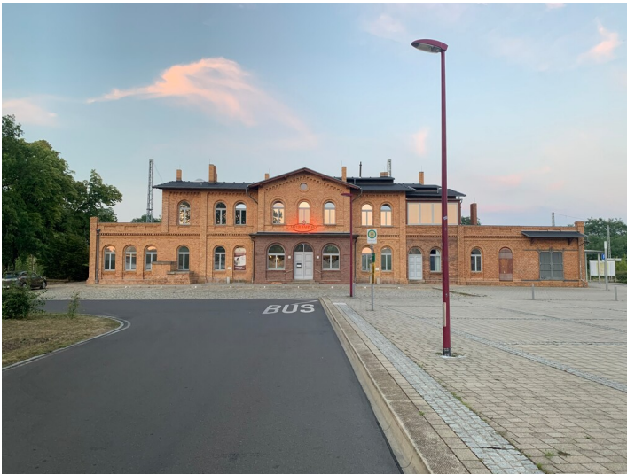
Großräscher Bahnhof Fotograf/Urheber: Kaja Boelcke
