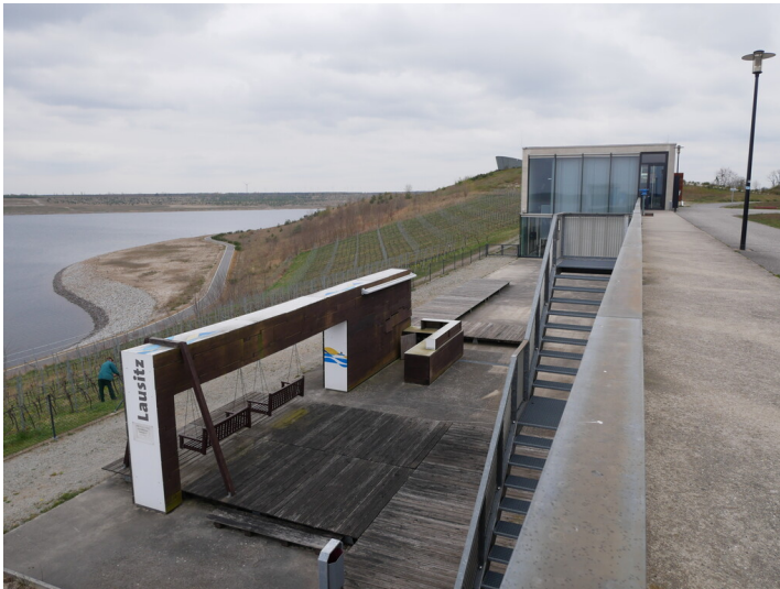
Pavillons der IBA-Terrassen Fotograf/Urheber: Kaja Boelcke
