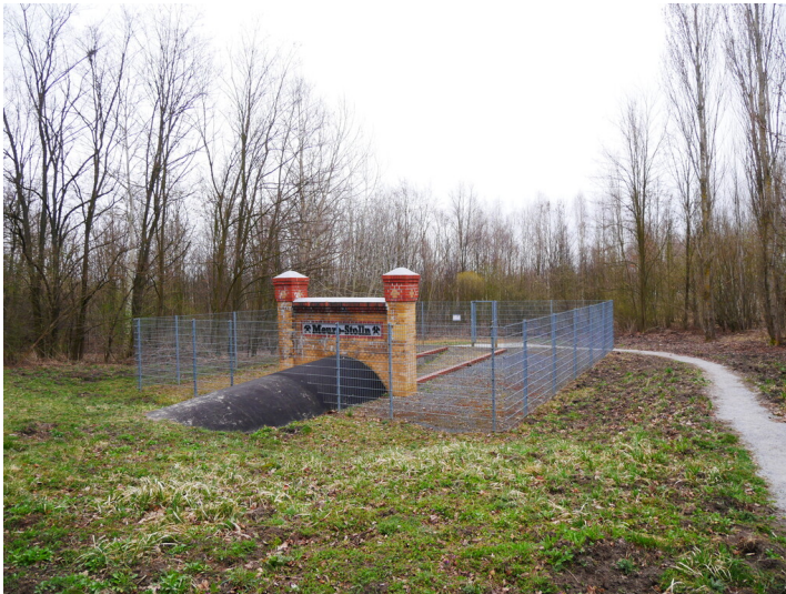
Mundloch Meurostolln Fotograf/Urheber: Kirsten Krepelin
