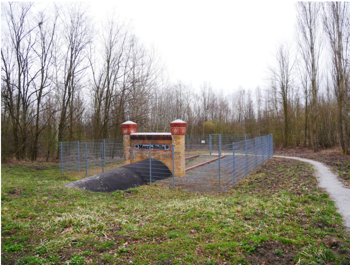
Mundloch Meurostolln Fotograf/Urheber: Kirsten Krepelin
