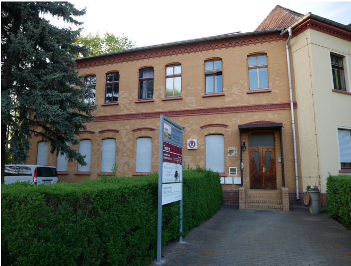
Werkskontor Brikettfabrik Meurostolln Fotograf/Urheber: Tanja Trittel
