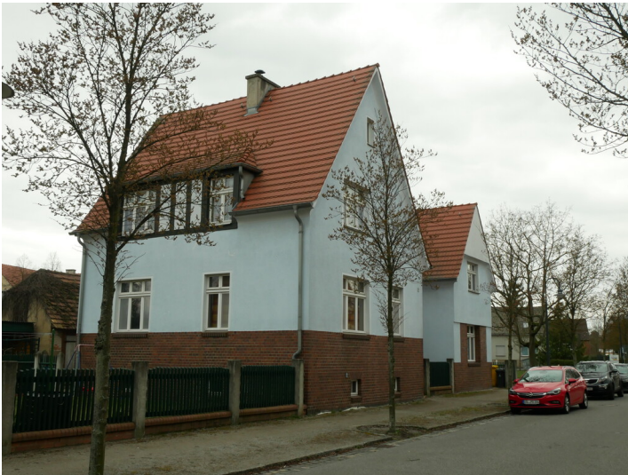
Wohngebäude de Kolonie Marga Fotograf/Urheber: Kaja Boelcke
