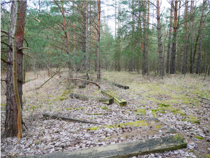
Gleise des stillgelegten Bereichs der Bahnstrecke Lübbenau-Kamenz Fotograf/Urheber: Kirsten Krepelin
