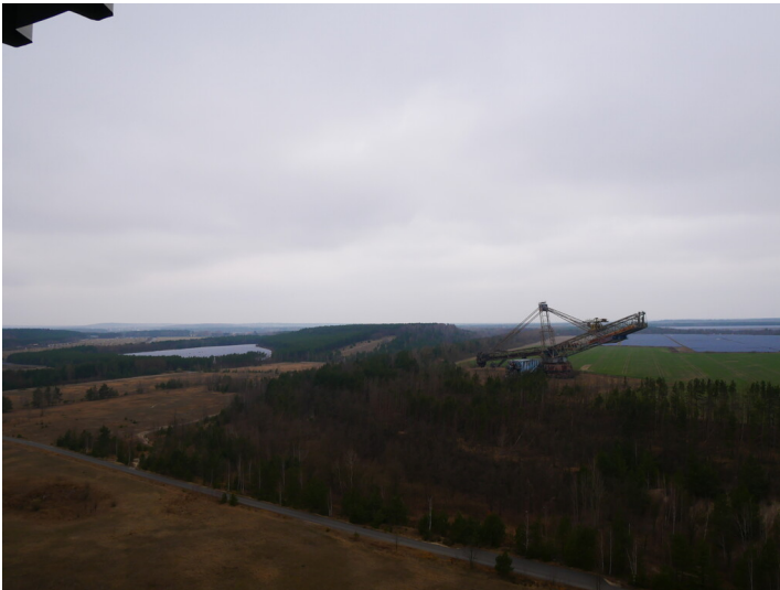
Aussichtsturm Hörlitz Meurostolln Fotograf/Urheber: Kirsten Krepelin
