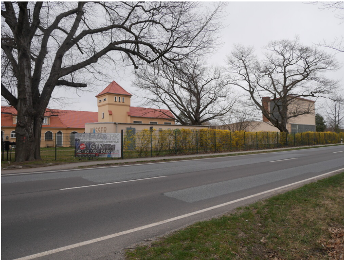
Wasserwerk Buchwalde Fotograf/Urheber: Franz Dietzmann
