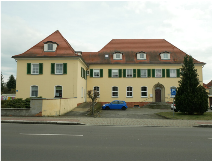
Amts- und Wohngebäude Fotograf/Urheber: Dr. Barbara Kündiger
