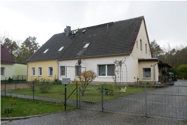
Tiefbauschacht Helma Fotograf/Urheber: Kaja Boelcke
