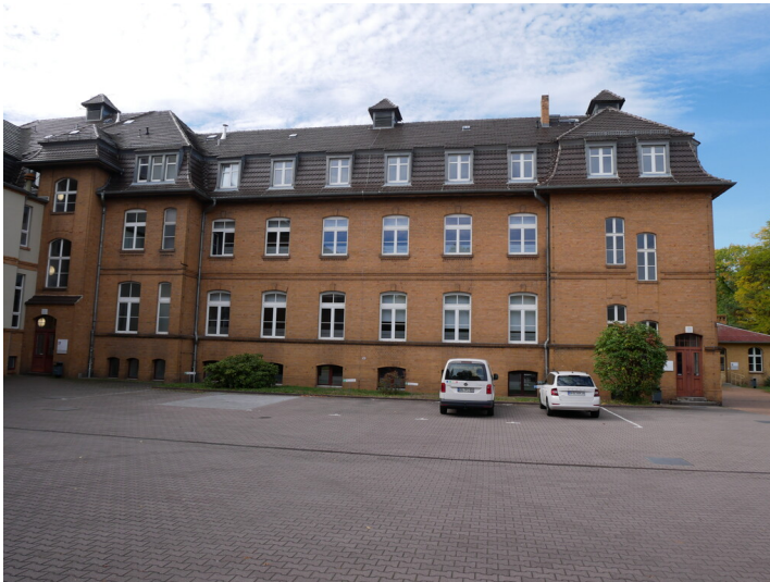
Haupthaus des ehemaligen Bergmanskrankenhaus Klettwitz Fotograf/Urheber: Franz Dietzmann
