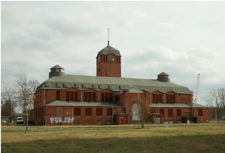
Badehaus und Verwaltungsgebäude der Brikettfabrik Marga Fotograf/Urheber: Kaja Boelcke
