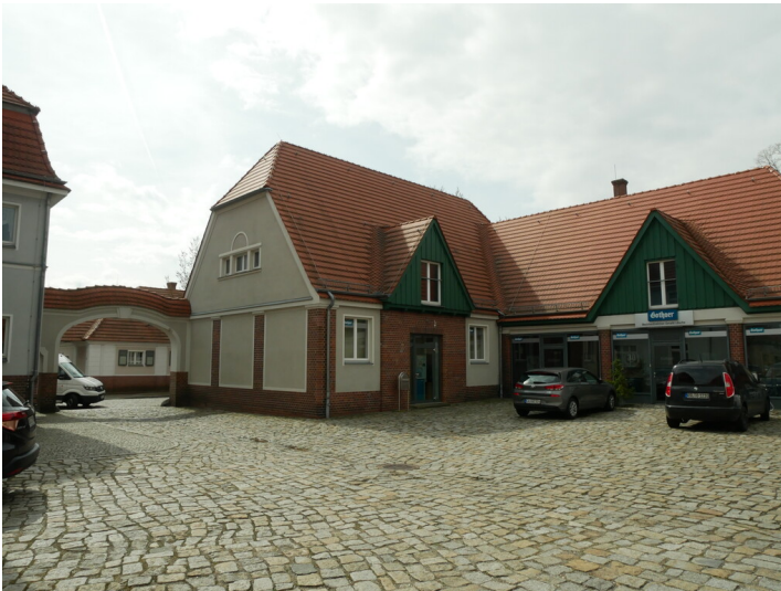
Versorgungsbauten am zentralen Platz und in Hoflage in der Kolonie Marga Fotograf/Urheber: Kaja Boelcke
