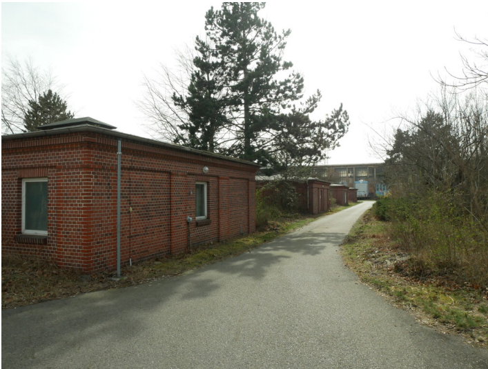
Gebäude des Ledigenwohnheims Brieske/Brikettfabrik Marga Häuser 1-8 Fotograf/Urheber: Kaja Boelcke
