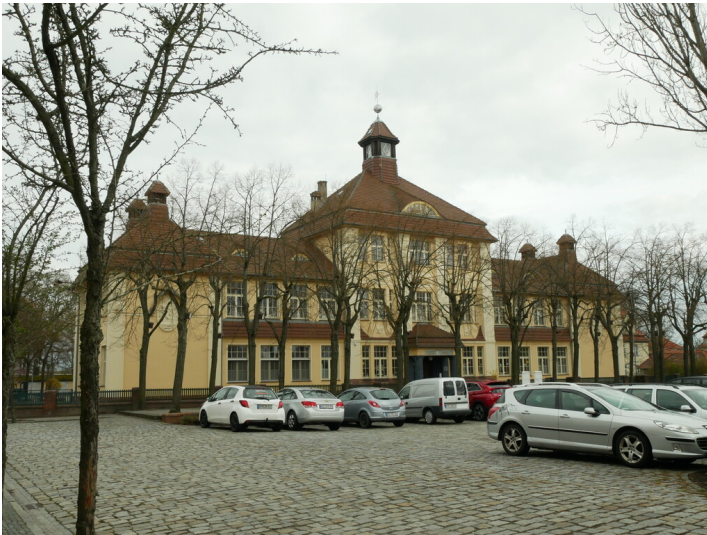
ehem. Schule der Kolonie Marga Fotograf/Urheber: Kaja Boelcke
