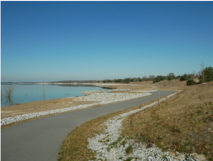
Einlauf Oberer Landgraben in Sedlitzer See Fotograf/Urheber: Kirsten Krepelin
