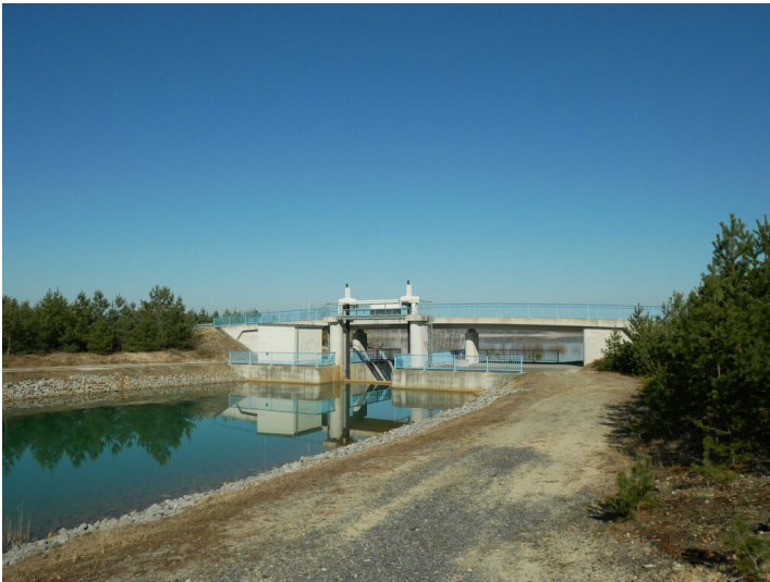
Rosendorfer Kanal (Überleiter 8) Fotograf/Urheber: Kirsten Krepelin
