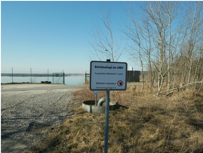
Pumpstation Bahnsdorf Fotograf/Urheber: Kirsten Krepelin
