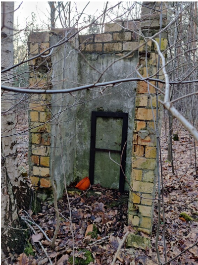
Fragment aufstrebenden Mauerwerks, evtl. Wirtschaftsbahn Grube Julius Fotograf/Urheber: Dr. Barbara Kündiger
