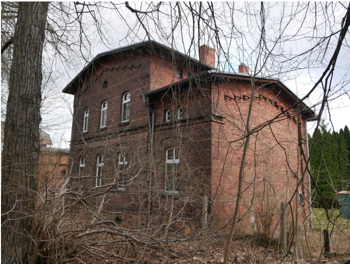
Wohnhaus unmittelbar in Nähe des Bahnhofs Döbern Fotograf/Urheber: Kaja Boelcke
