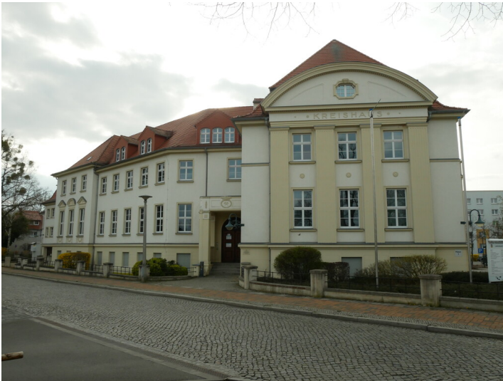
Kreishaus, bestehend aus Haupt- und Nebengebäude mit Einfriedung Fotograf/Urheber: Dr. Barbara Kündiger
