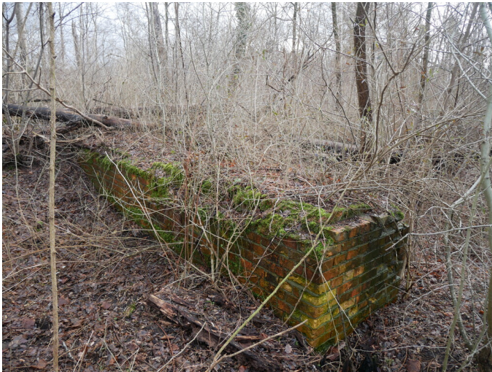
verm. Fragmente aufstrebenden Mauerwerks einer Brikettfabrik Fotograf/Urheber: Kirsten Krepelin
