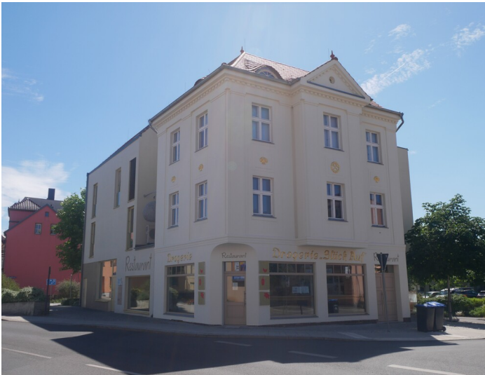
Wohngebäude mit ehemaliger Drogerie Fotograf/Urheber: Kaja Boelcke
