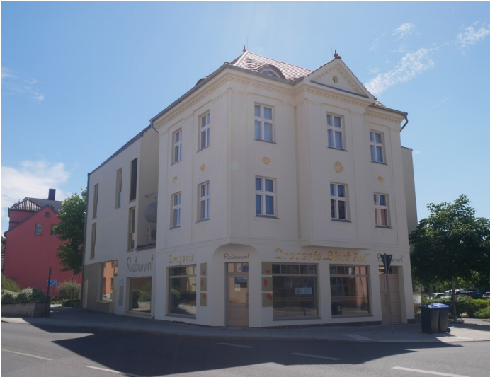
Wohngebäude mit ehemaliger Drogerie Fotograf/Urheber: Kaja Boelcke
