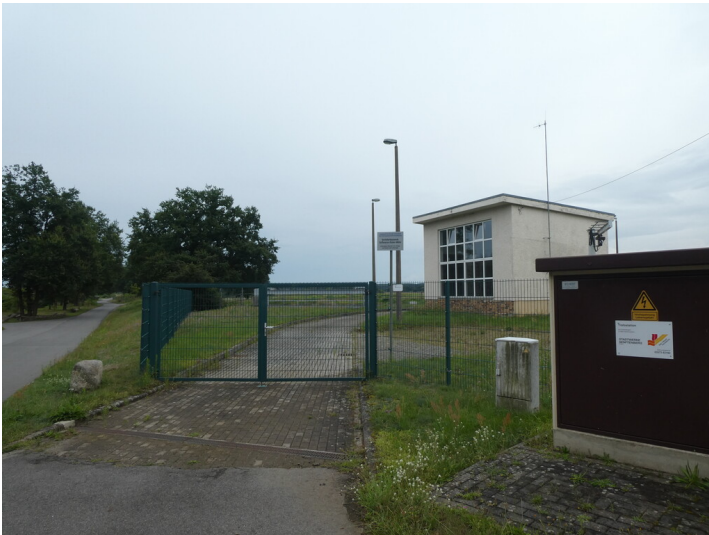
Verteilerbauwerk Schwarze-Elster-Wehr Fotograf/Urheber: Kirsten Krepelin
