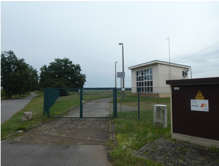
Verteilerbauwerk Schwarze-Elster-Wehr Fotograf/Urheber: Kirsten Krepelin
