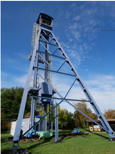
Schachtentwässerungsanlage Klettwitz Fotograf/Urheber: Tanja Trittel
