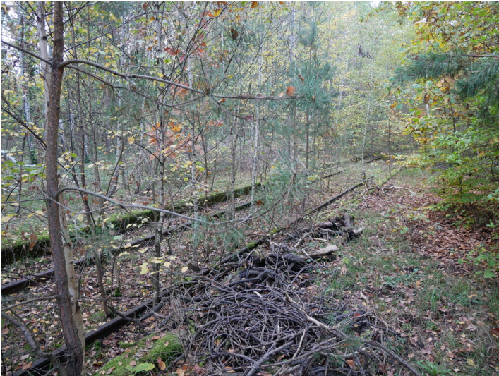
Zschipkau-Finsterwalder Eisenbahnstrecke Fotograf/Urheber: Franz Dietzmann
