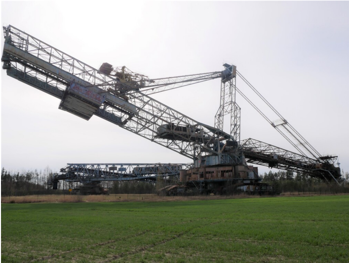
Schaufelradbagger SRs 1500 mit Rücklader (Verladegerät) Fotograf/Urheber: Tanja Trittel
